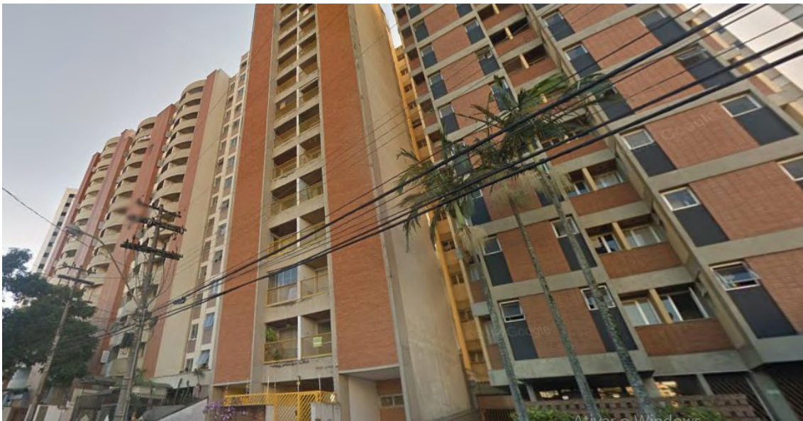
Figura 28. Residencial multifamiliar – Rua Dr. Antônio Álvares Lobo.
