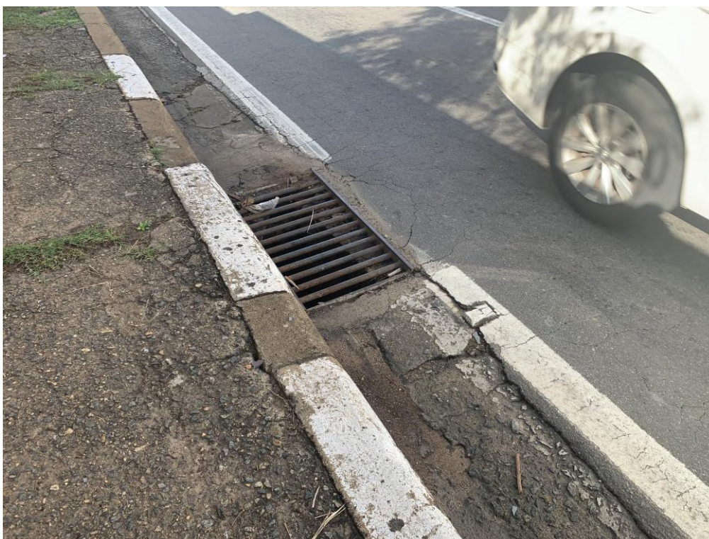
Figura 35. Boca de lobo na Avenida Barão de Itapura.
