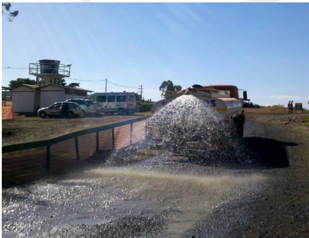
Figura 15. Exemplo de umidificação de via da obra. Fonte: Global Vias.
