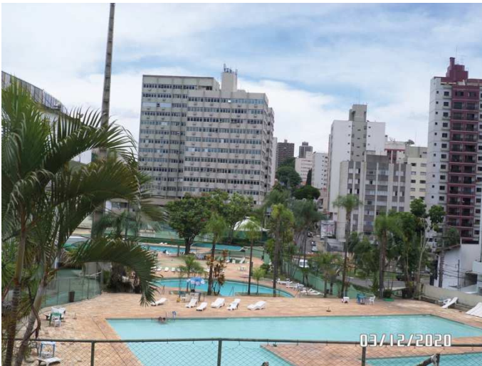
Foto 10. Vista do complexo aquático a ser demolido na porção oeste do empreendimento.
