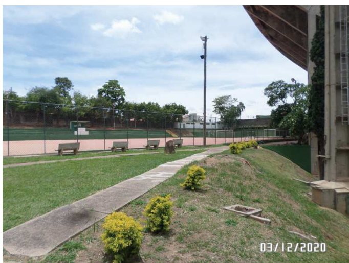
Foto 8. Outra vista de marquise de arquibancada a ser demolida na porção central do terreno.
