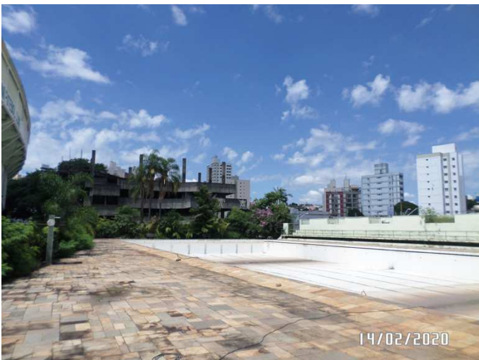
Foto 3. Detalhe de piscina desativada a ser demolida na porção oeste do empreendimento.
