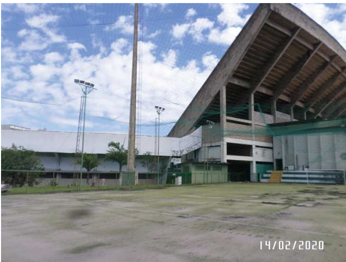
Foto 2. Outra vista de arquibancada a ser demolida e área de quadra na porção sudeste do empreendimento.
