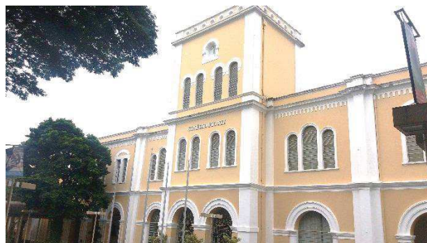
Foto 3-23 – vista do colégio Pio XII, na Rua Boa Ventura do Amaral
