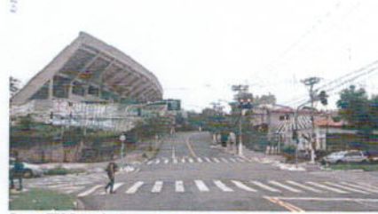
Vista da Av. Guarani, esquina com a Av. Imperatriz D. Tereza Cristina
