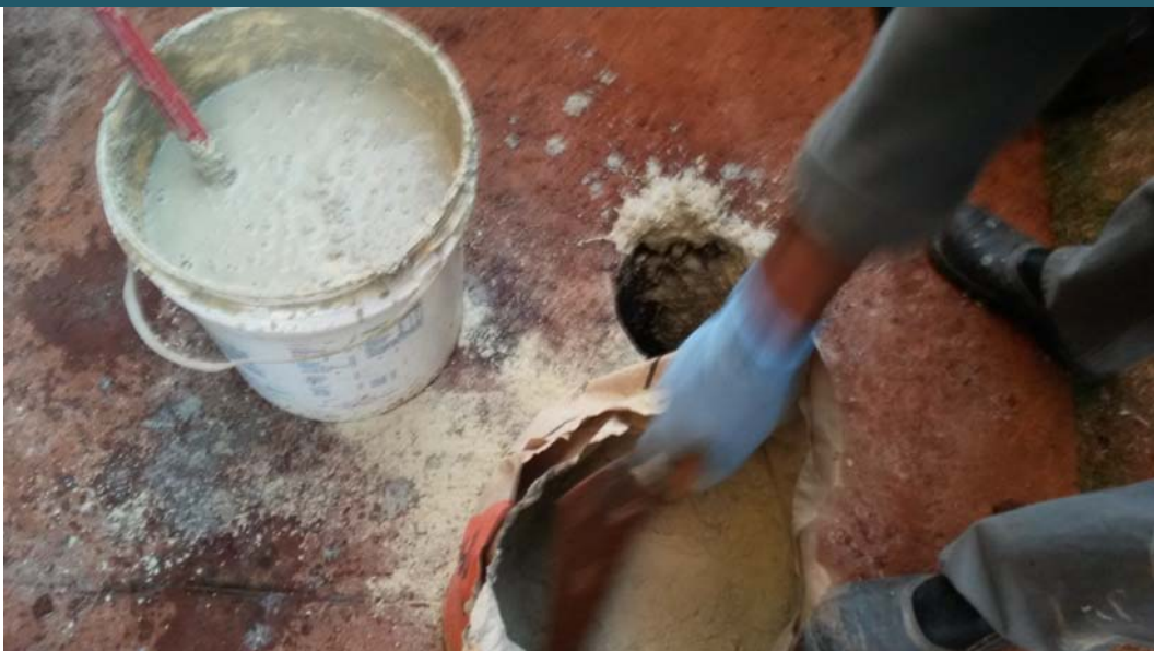
Foto 04 – Preenchimento da Sondagem com Calda de Bentonita e Cimento
