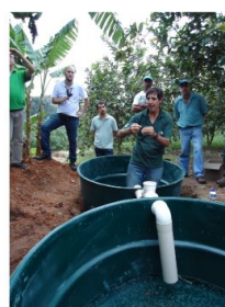
Fossa Séptica Biodigestora instalada em Campinas. Foto: Renato Marinho.
