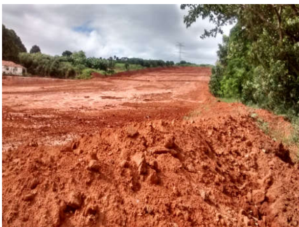
Obra de terraplanagem.
