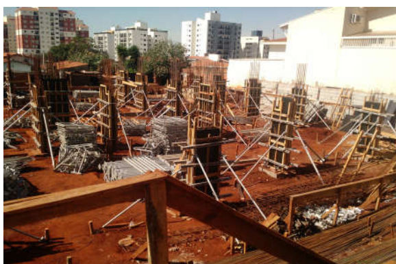
Obra de edificação.
