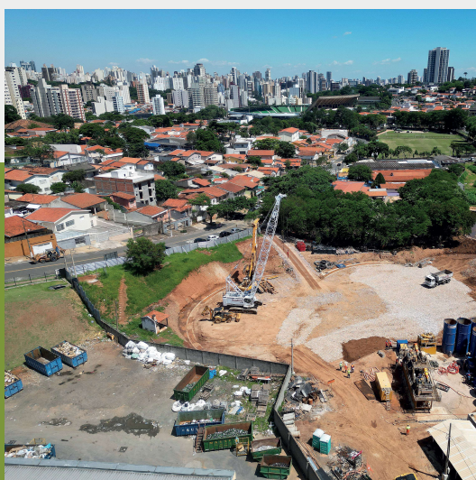
Primeiro reservatório do pacote de obras antienchente já está em obras na região do Proença
