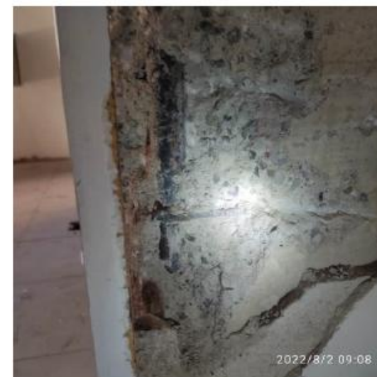
Figura 19 – Barra lisa (Pilar do prédio antigo, prospectada pelo cliente.
