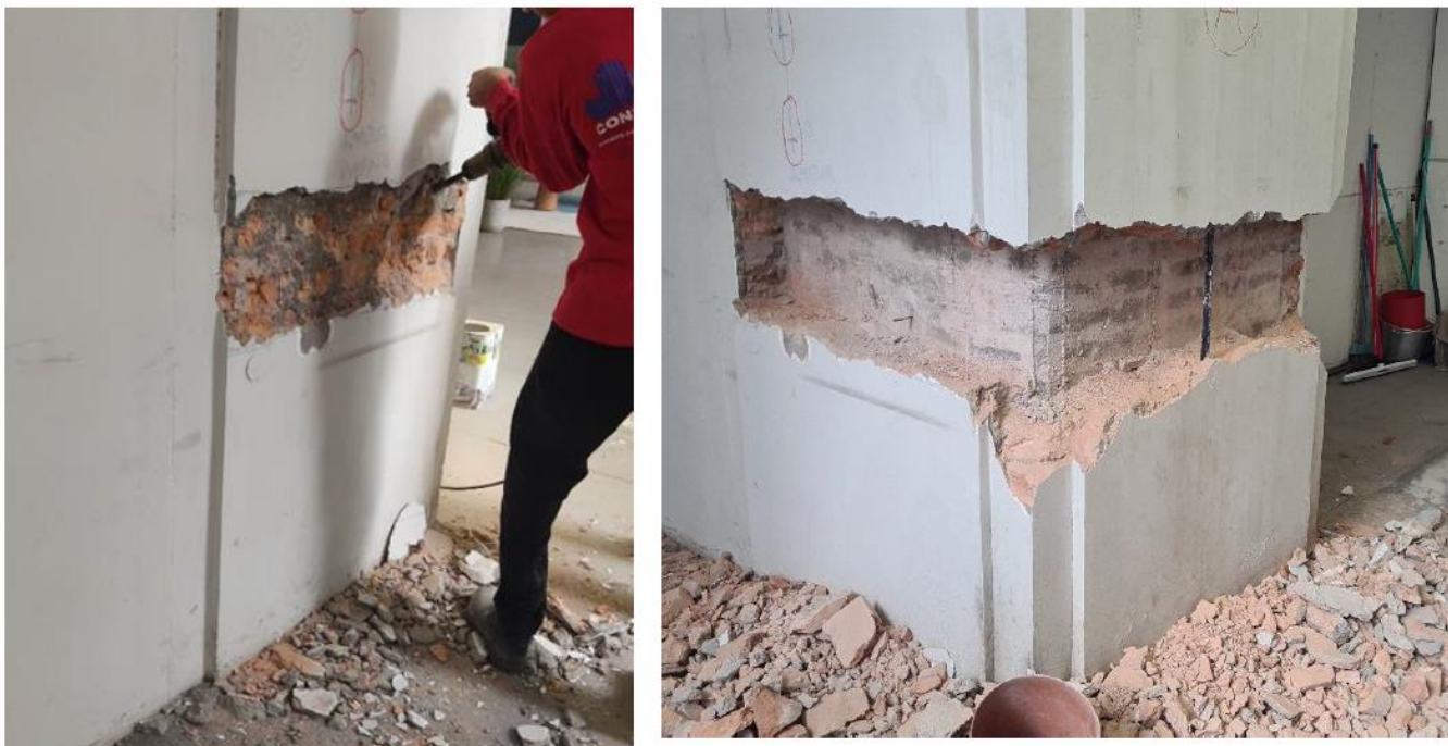
Figura 20 - Remoção de Revestimento de elevada espessura no Pilar B (à esquerda) & Seção exposta ( à direita)
