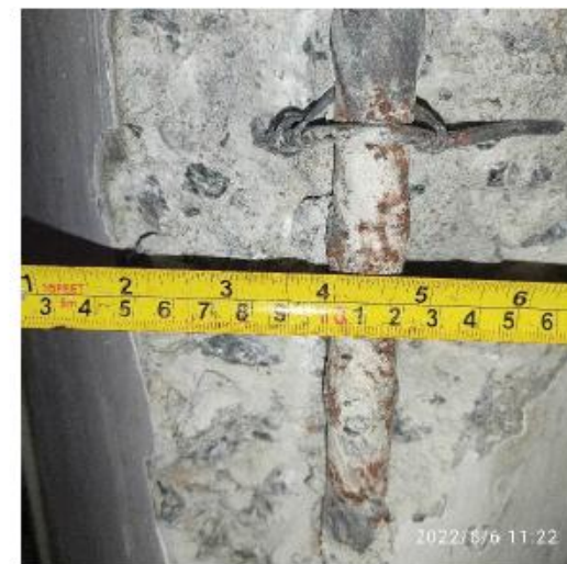
Figura 18 – Barra com nervura em hélice (Pilar C – Pavimento Térreo)
