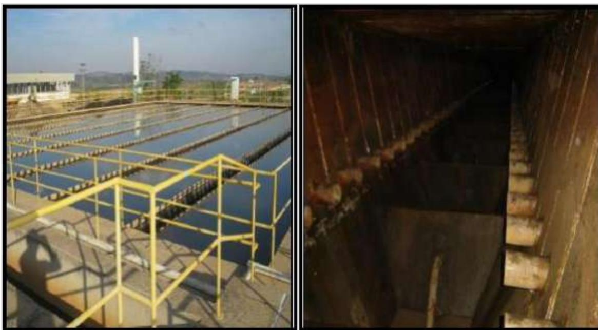
**Figura 4.7: Área Superficial do Decantador da ETA 04 (Esquerda). Parte Interna do Decantador (Direita). Fonte: SANASA (2021).**
