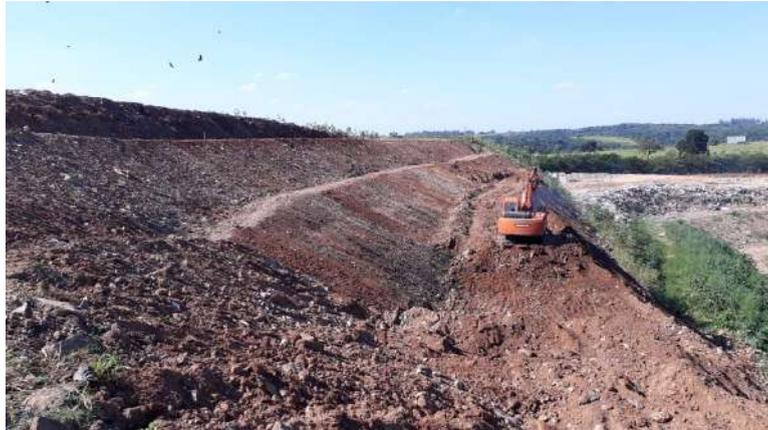
**Figura 6.70 Retaludamento ajustes geométricos do maciço.**
