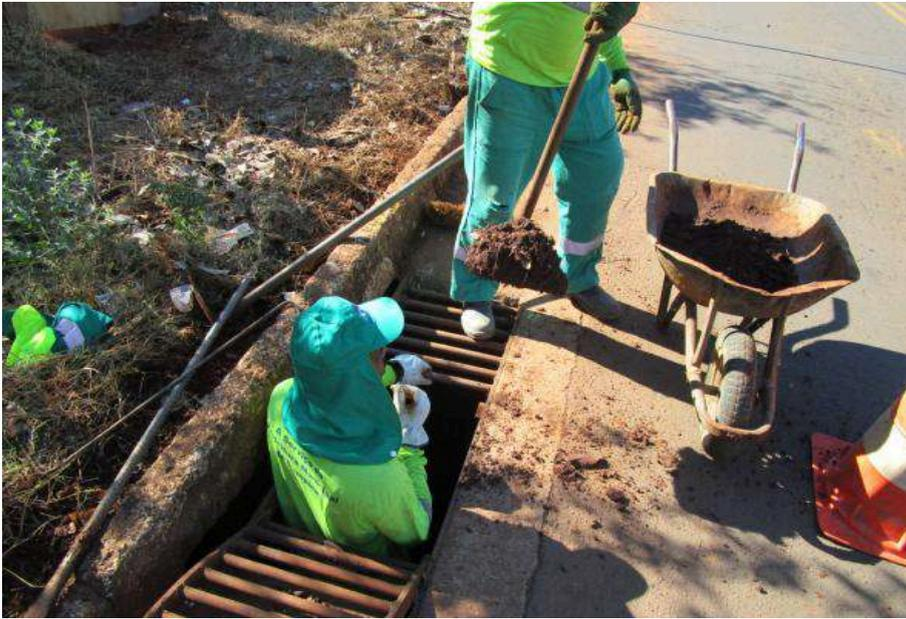
**Figura 6.34: Limpeza Manual de Boca de Lobo**
