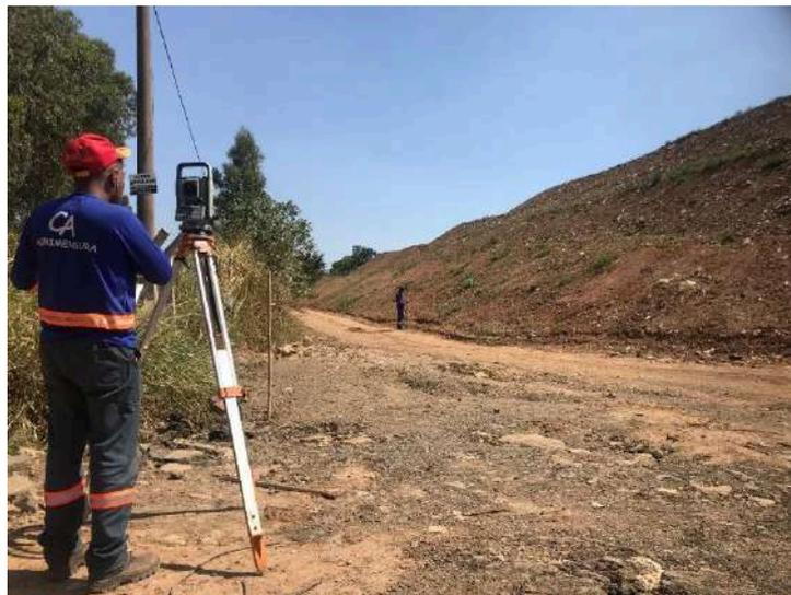
**Figura 6.69: Levantamento planimétrico por área, inicialmente no setor sudoeste, para iniciar os serviços de plantio de grama e sistema de escoamento pluvial.**
