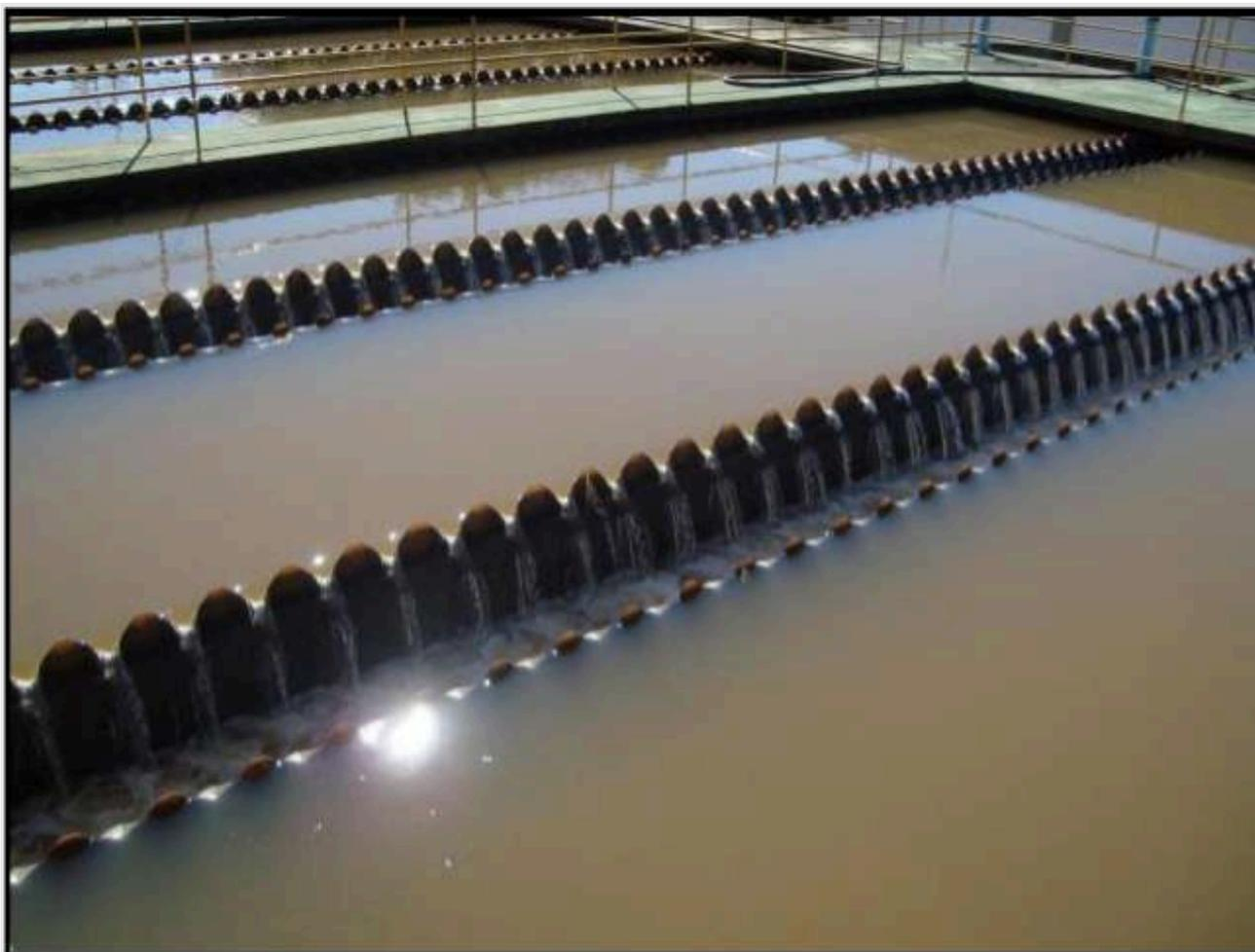
**Figura 4.4: Pré-sedimentador de Fluxo Ascensional das ETA 03 e 04. Fonte: SANASA (2021).**
