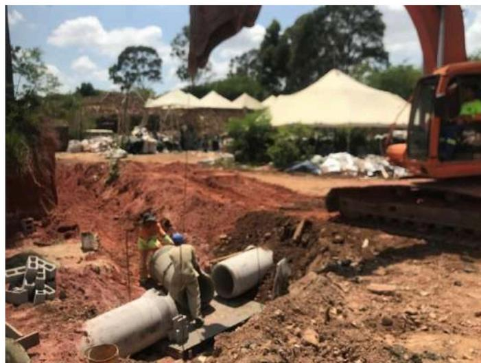
**Figura 6.55: Implantação drenagem pluvial.**
