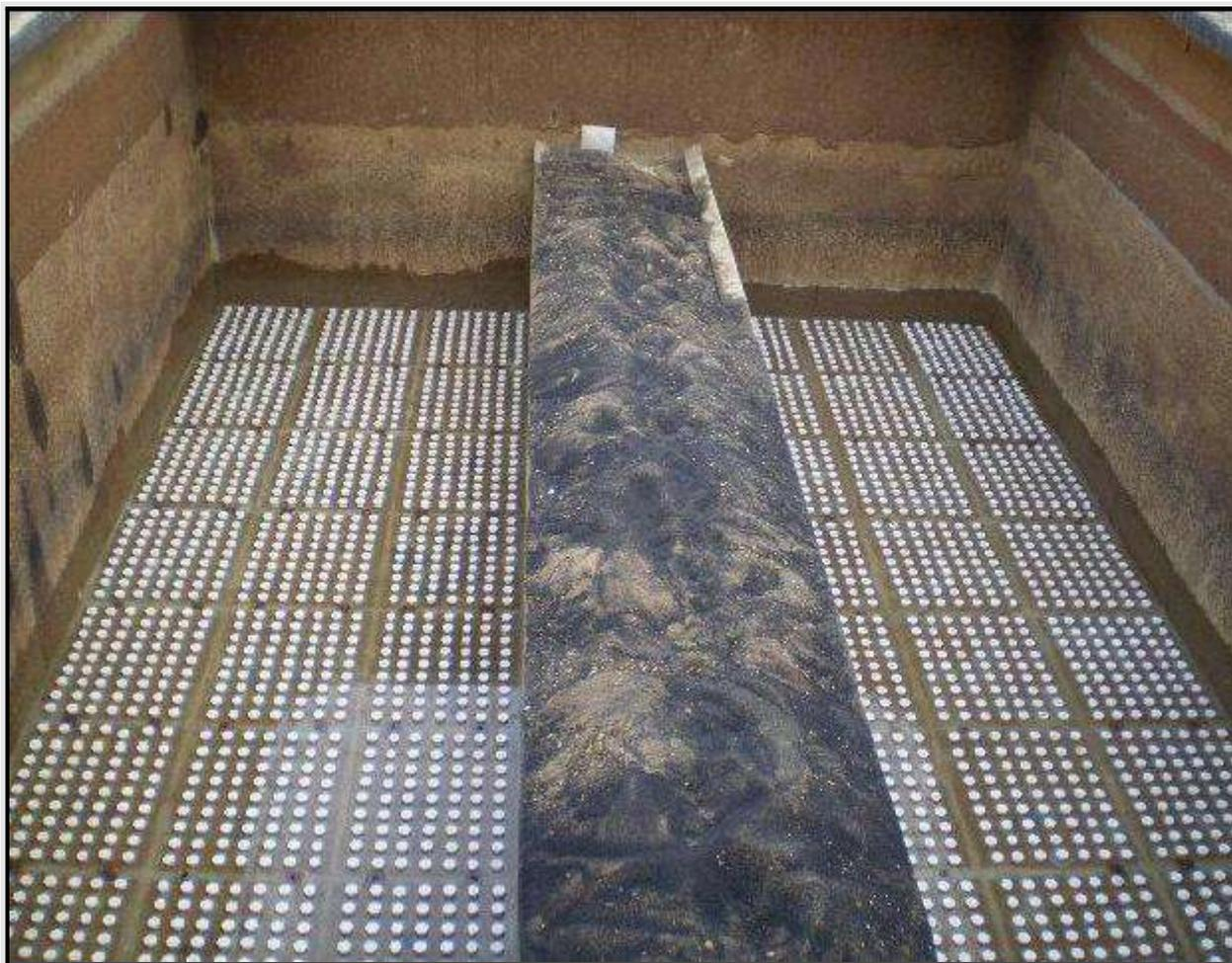
**Figura 4.9: Filtro da ETA 04 sem o Material Filtrante. Fonte: SANASA (2021).**
