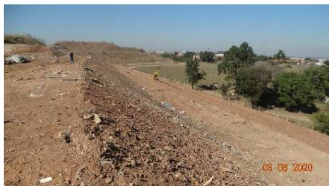
**Figura 6.72: Retaludamento ajustes geométricos do maciço.**
