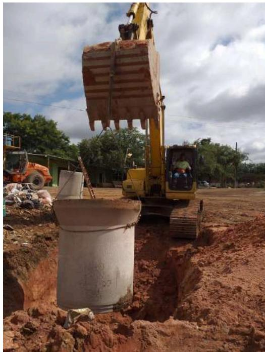
**Figura 6.57: Implantação drenagem pluvial.**
