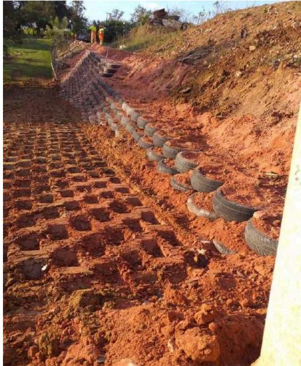
**Figura 6.66: Implantação de muro de contenção: muro arrimo.**
