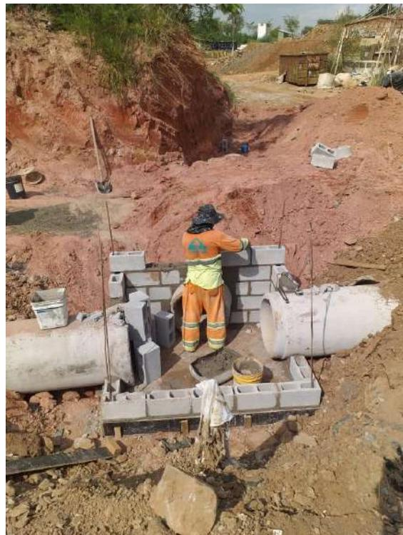
**Figura 6.59: Construção da caixa de passagem em alvenaria.**
