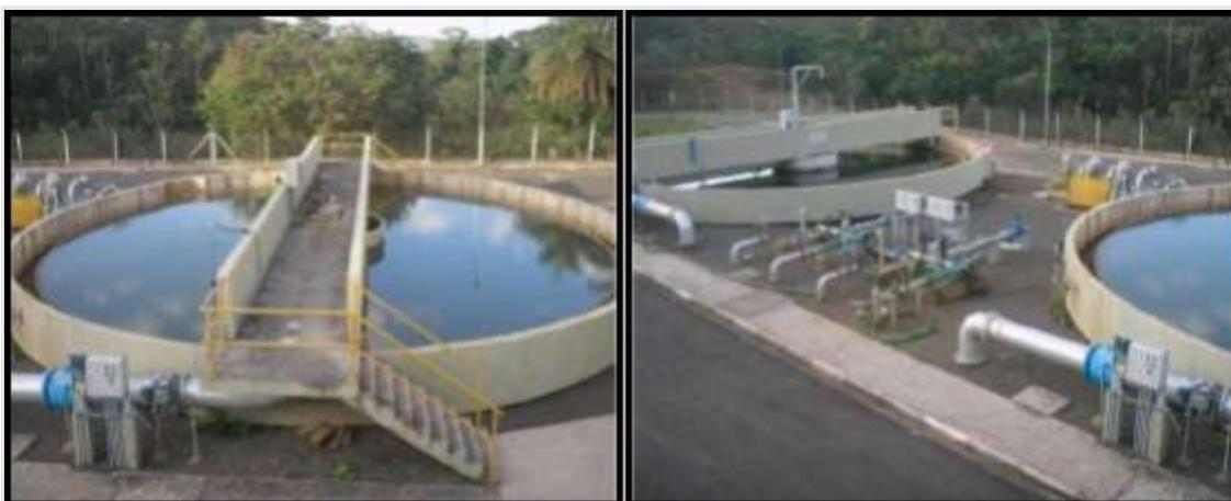
**Figura 4.12: Adensadores por gravidade instalados na ETL das ETA 3 e 4 da SANASA na cidade de Campinas. Fonte: SANASA (2021).**
