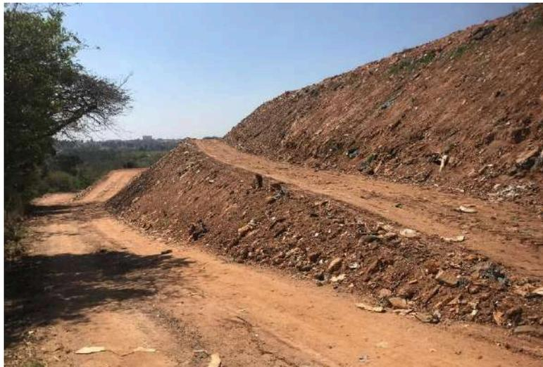
**Figura 6.67: Retaludamento ajustes geométricos do maciço.**
