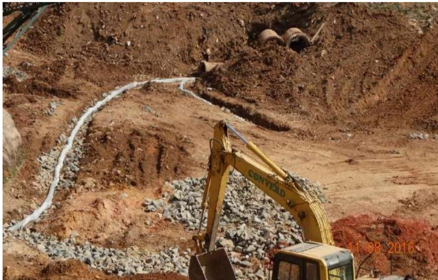
**Figura 6.63: Implantação drenagem pluvial.**
