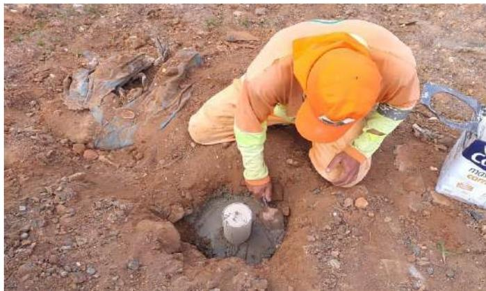
**Figura 6.75: Instalação de marcos superficiais de deslocamento.**
