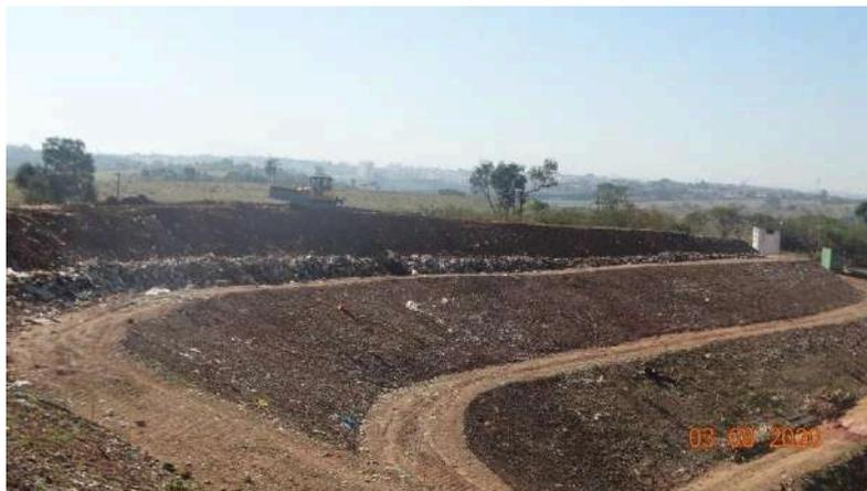
**Figura 6.71: Retaludamento ajustes geométricos do maciço.**
