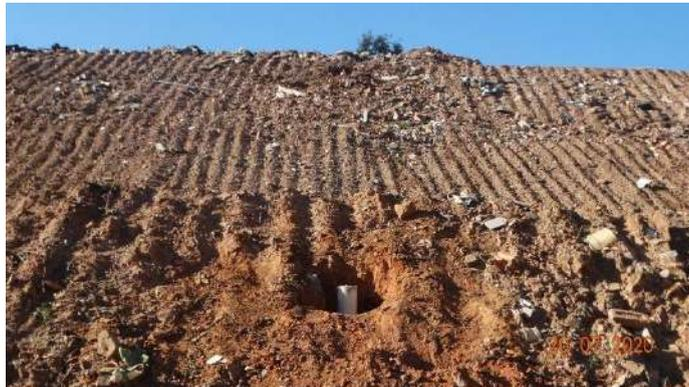
**Figura 6.74: Instalação de marcos superficiais de deslocamento.**
