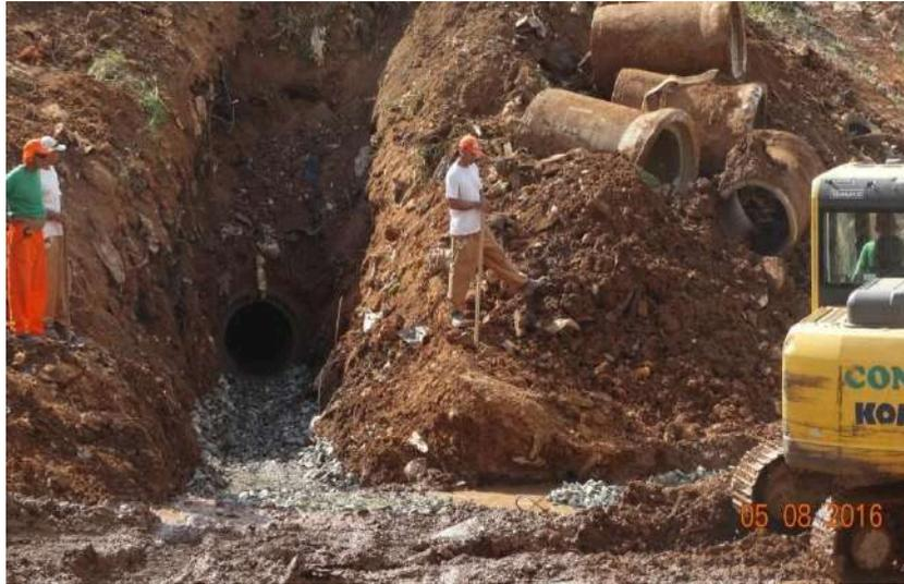
**Figura 6.62: Implantação drenagem pluvial.**
