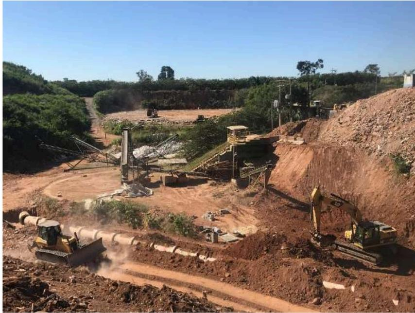
**Figura 6.64: Implantação drenagem pluvial.**
