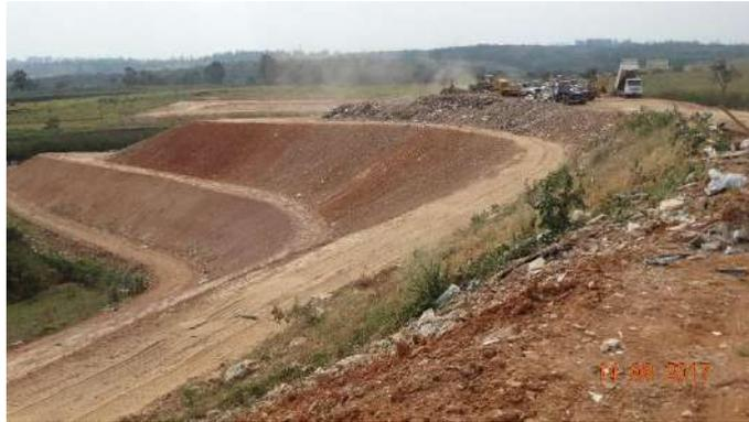
**Figura 6.73: Retaludamento ajustes geométricos do maciço.**
