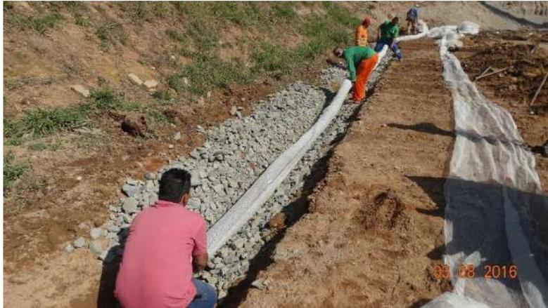
**Figura 6.60: Implantação drenagem pluvial.**
