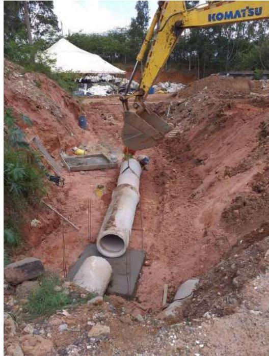
**Figura 6.58: Implantação drenagem pluvial.**
