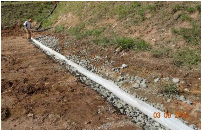
**Figura 6.61: Implantação drenagem pluvial.**
