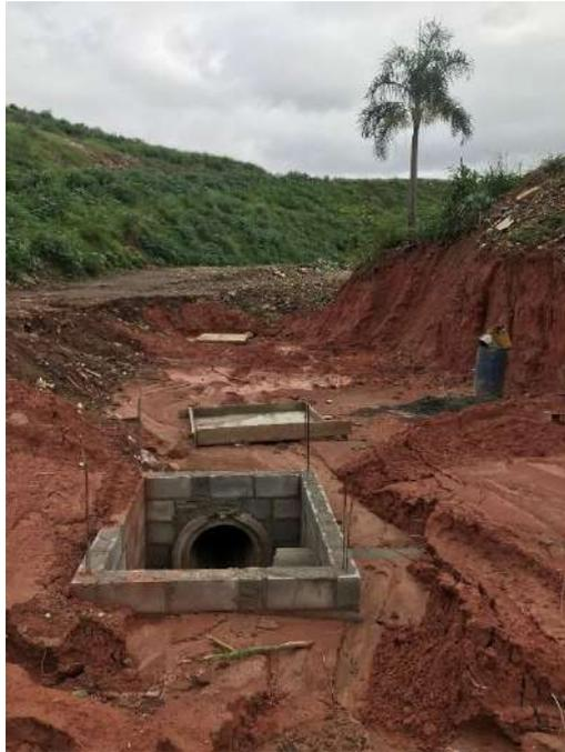
**Figura 6.56: Construção da caixa de passagem em alvenaria.**
