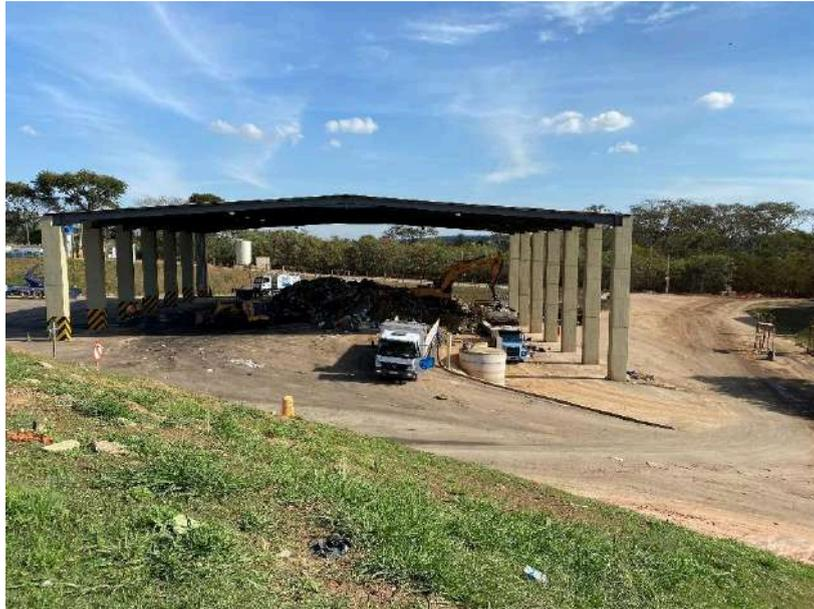
**Figura 6.9: Estação de Transferência e Transbordo, com detalhe para o desnível entre a pátio de descarga e área de transferência (carretas)**
