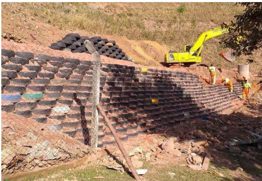
**Figura 6.65: Implantação de muro de contenção: muro arrimo**
