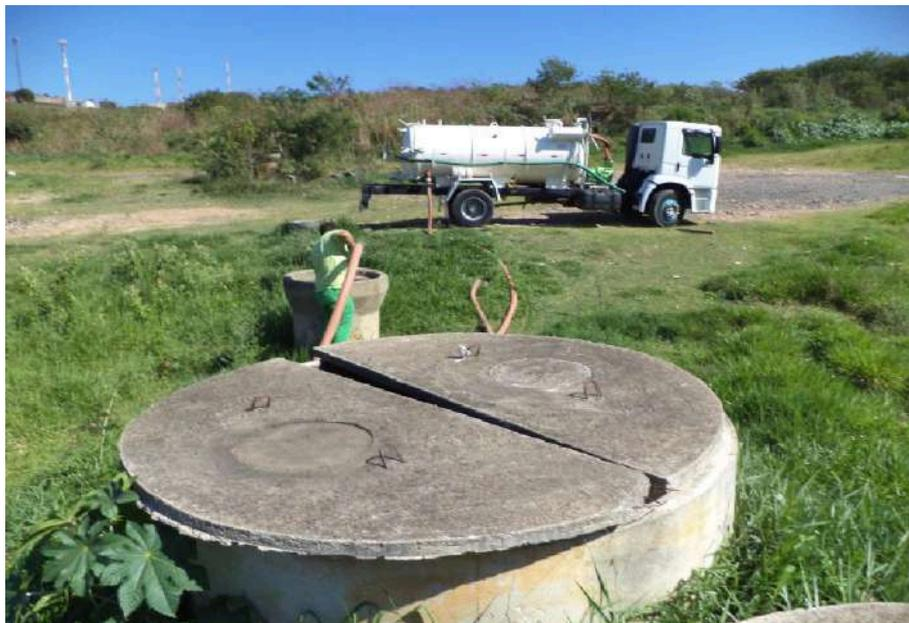
**Figura 6.106: Reservatório de chorume e transferência para tratamento (ETE Piçarrão).**
