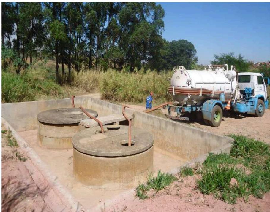
**Figura 6.119: Reservatório de chorume e transferência para tratamento (ETE Piçarrão).**
