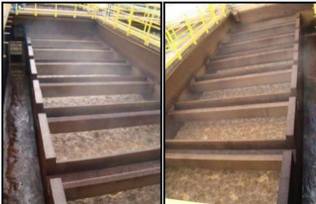
**Figura 4.8:** Filtro da ETA 03 em processo de limpeza. Fonte: SANASA (2021).
