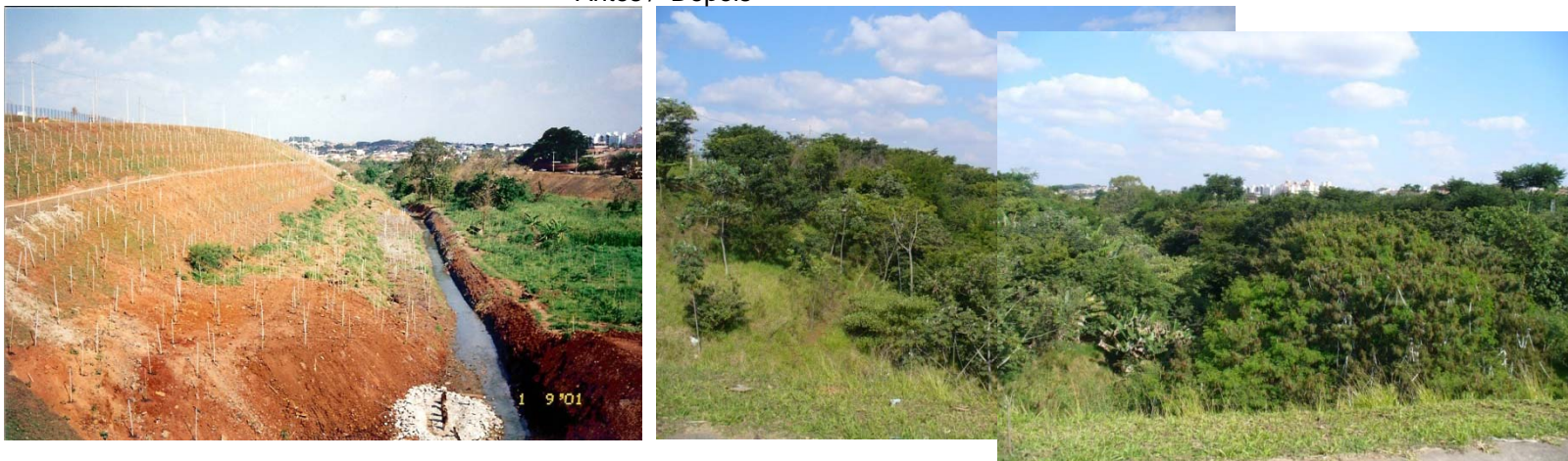
Fotos 29 e 30: Vista de talude executado para implantação de sistema viário e desassoreamento do ribeirão das Pedras, em 2.001. Em 2008, observa-se a densa vegetação ciliar existente, após o trabalho de restauração. Vista obtida a partir da Rodovia Dom Pedro.
