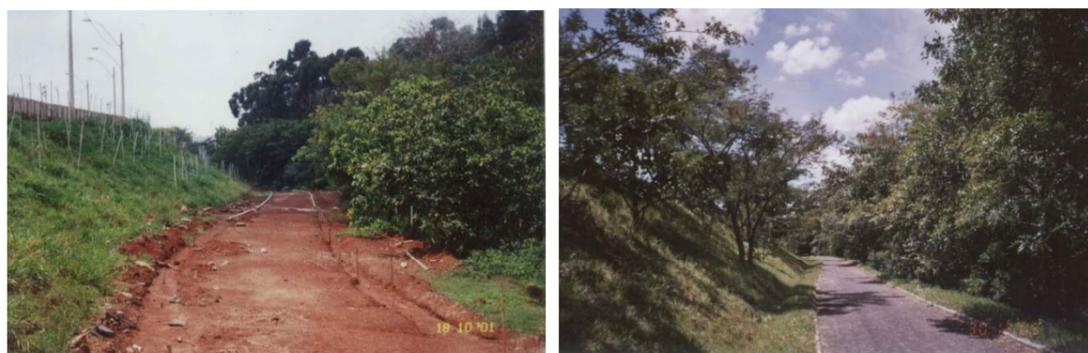
Fotos 27 e 28: Outra vista de trecho do parque linear, durante a execução das obras de infraestrutura e após a implantação da ciclovia no pé do talude do sistema viário e a restauração da mata ciliar do ribeirão das Pedras.
