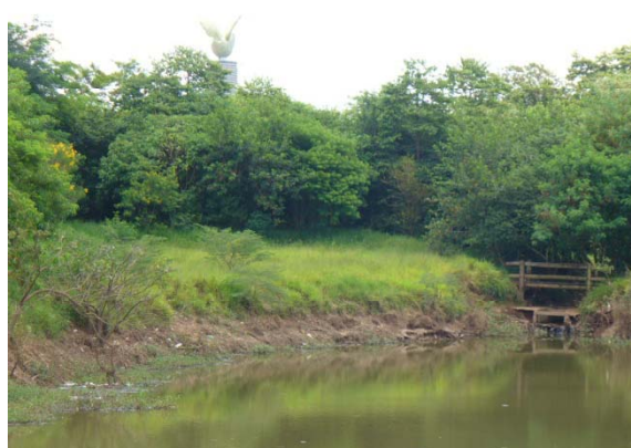
Fotos 2 e 3: Vista da lagoa de controle de cheias e de ação de educação ambiental com o envolvimento de 400 crianças da 4ª série no plantio da mata ciliar, em 2005. Em 2.009 observa-se a mata ciliar bem desenvolvida. Observa-se também a marca atingida pela água após forte chuva na região, demonstrando o desempenho da lagoa no amortecimento da onda de cheia da bacia, com o armazenamento temporário de cerca de 60.000.000 de litros de água.
