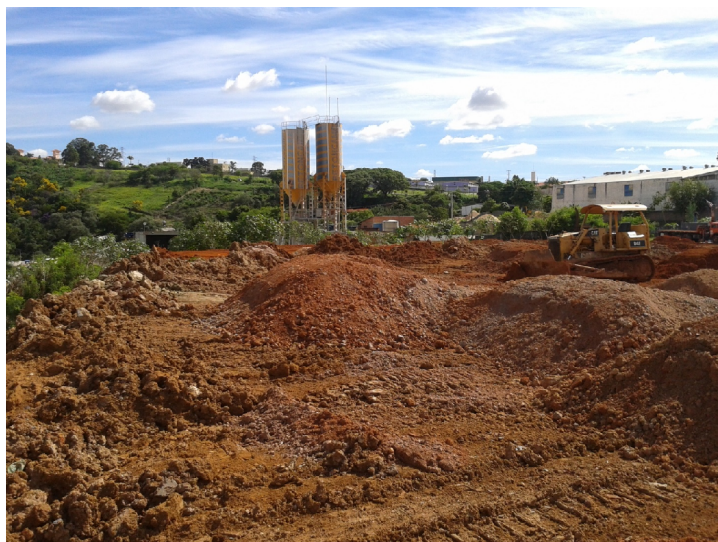
Obra de terraplanagem.
