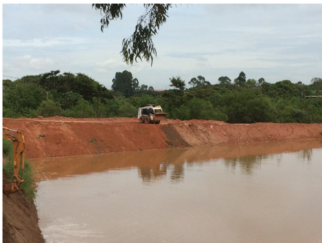
Obra de represamento.
