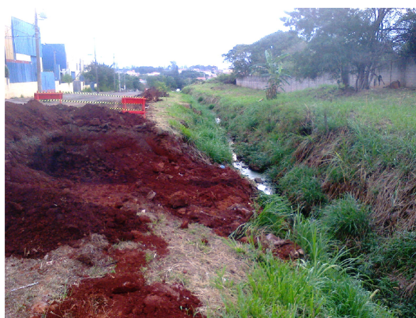
Desassoreamento de córrego.
