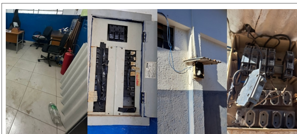
Figura 24: Extintor em local indevido e quadros de energia precários.
