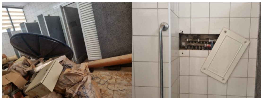
Figura 49: Entulhos e registro exposto - Complexo Aquático.
