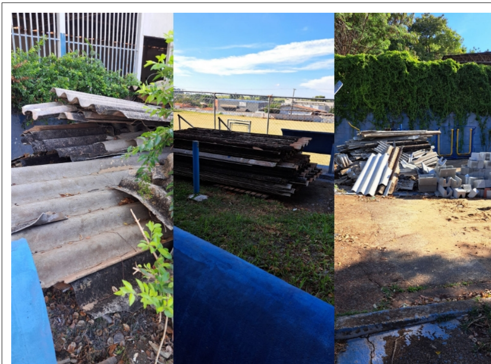
Figura 20: Materiais de construção e telhas de amianto em local inadequado.
