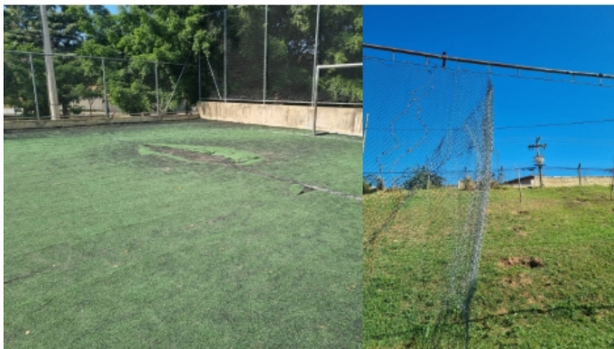
Figura 43: Piso campo society e alambrado quadra poliesportiva danificados.
