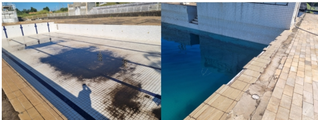
Figura 51: Piscina desativada e bordas quebradas - Complexo Aquático.
