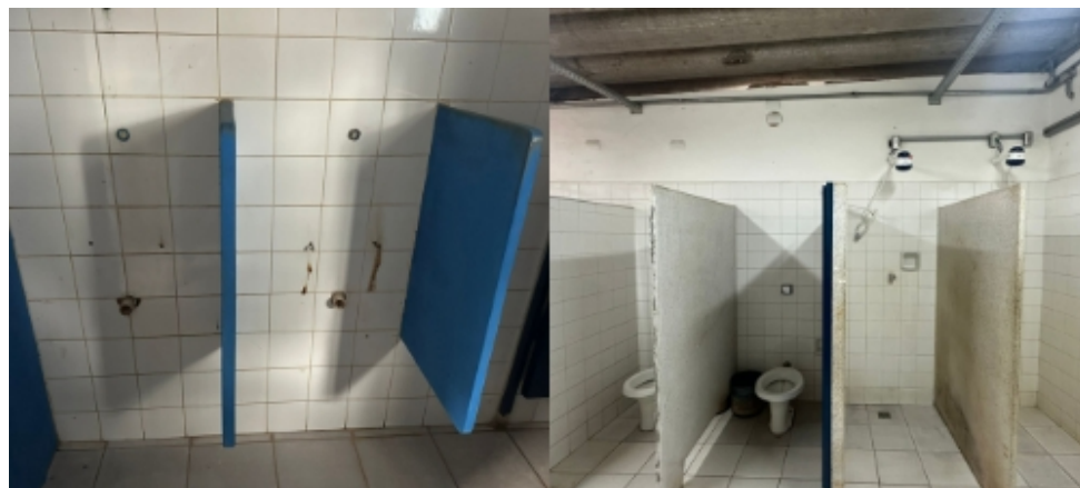
Figura 30: Ausência de mictórios e vasos sanitários quebrados.
