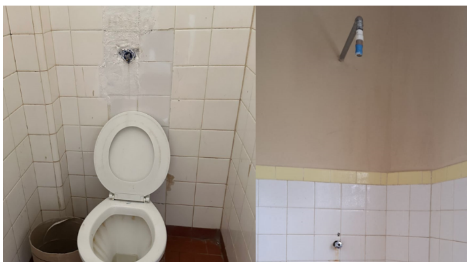
Figura 17: Válvula de descarga com defeito e chuveiro precário.
