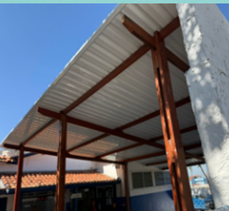
Reforma do Telhado
