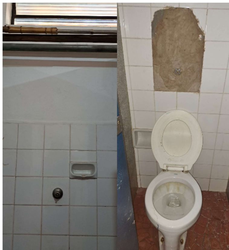
Figura 44: Banheiros sem chuveiros, danificados e sem higienização adequada.
