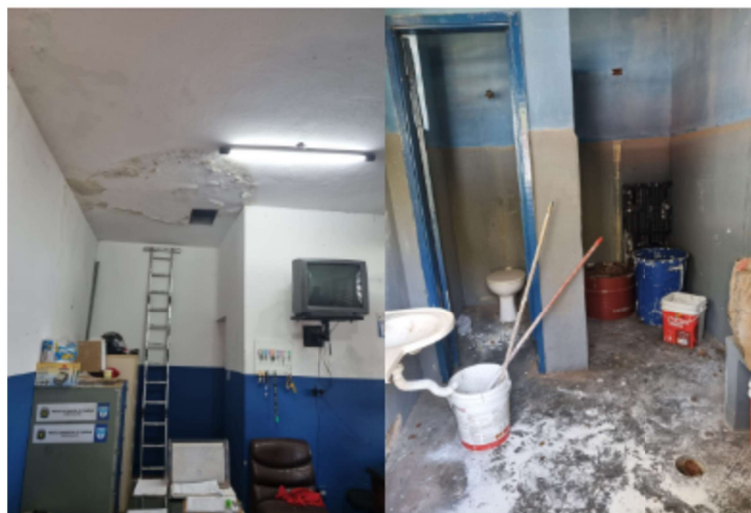
Figura 39: Infiltrações na área administrativa e materiais diversos no banheiro do campo de futebol.
