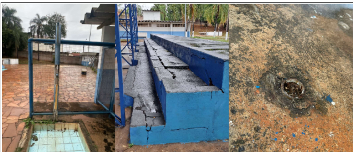
Figura 31: Área da piscina degradada, arquibancada quebrada e abertura afiada no chão da piscina.
