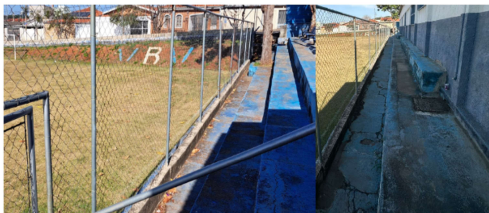
Figura 26: Acessibilidade do campo e condição das arquibancadas.
