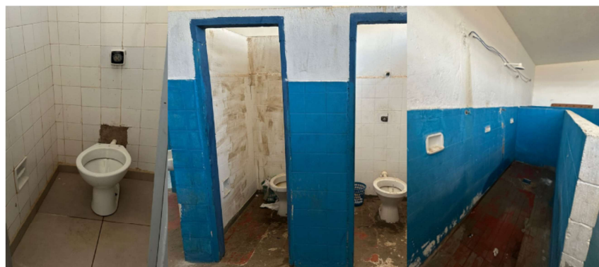
Figura 22: Sanitários em condições precárias. Faltando válvula e tampas.
