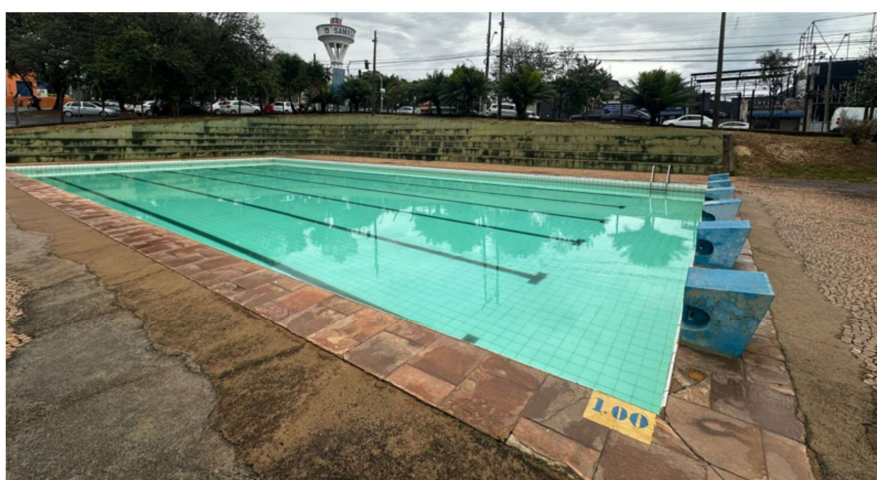
Figura 18: Piscina sem rampas, escadas e corrimãos acessíveis.
