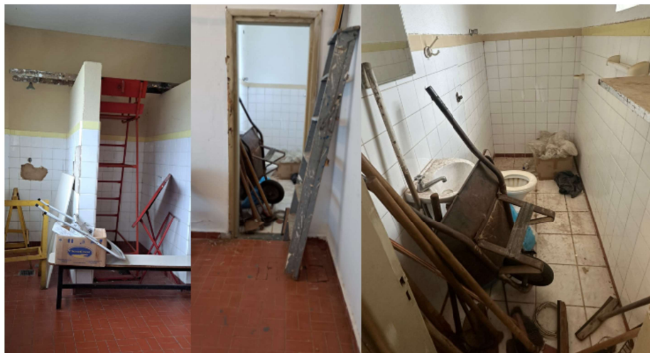
Figura 16: Armazenamento indevido de equipamentos e ferramentas.
