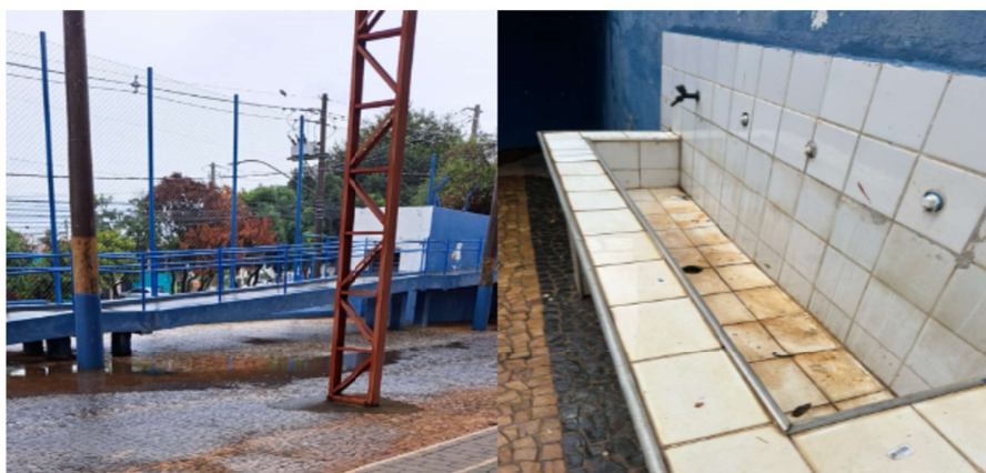
Figura 1: Acúmulo de água e pia inutilizada devido a vazamento.
