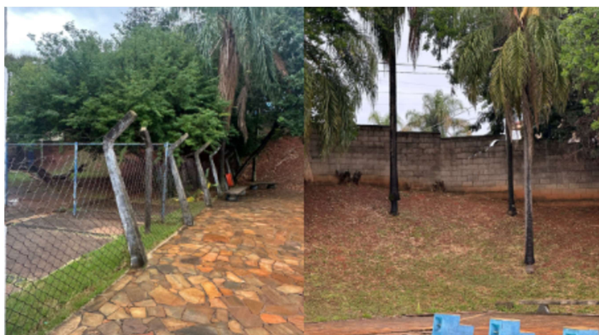
Figura 28: Alambrado interno e muro quebrado.
