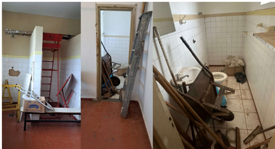
Figura 16: Armazenamento indevido de equipamentos e ferramentas.
