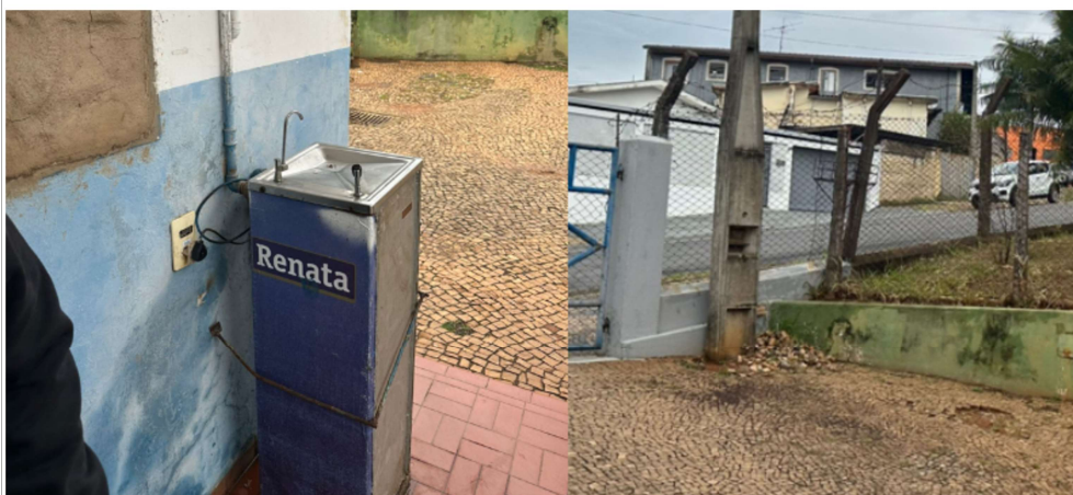
Figura 11: Bebedouro e alambrado externo com defeito.
