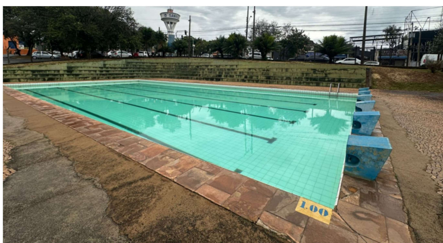
Figura 18: Piscina sem rampas, escadas e corrimãos acessíveis.
