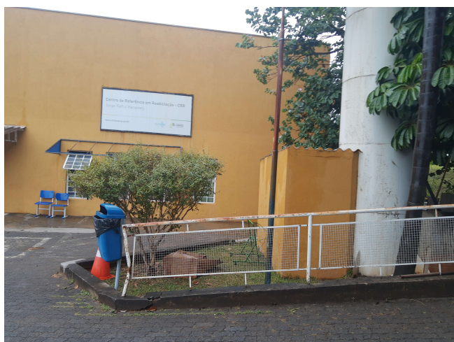
Foto 21 – Descida rampa no CRR em 2022.
