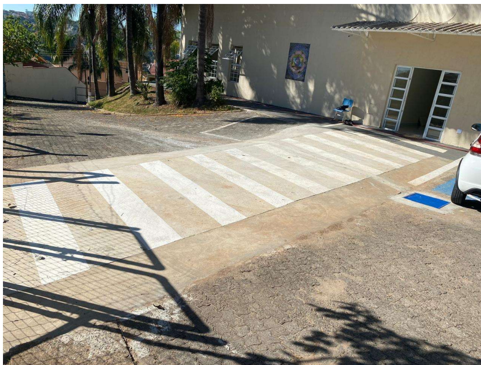
Foto 23 – Finalização da adequação no CRR em 2024.
