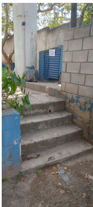
Foto 15 – Escada CS Padre Anchieta em 2024
