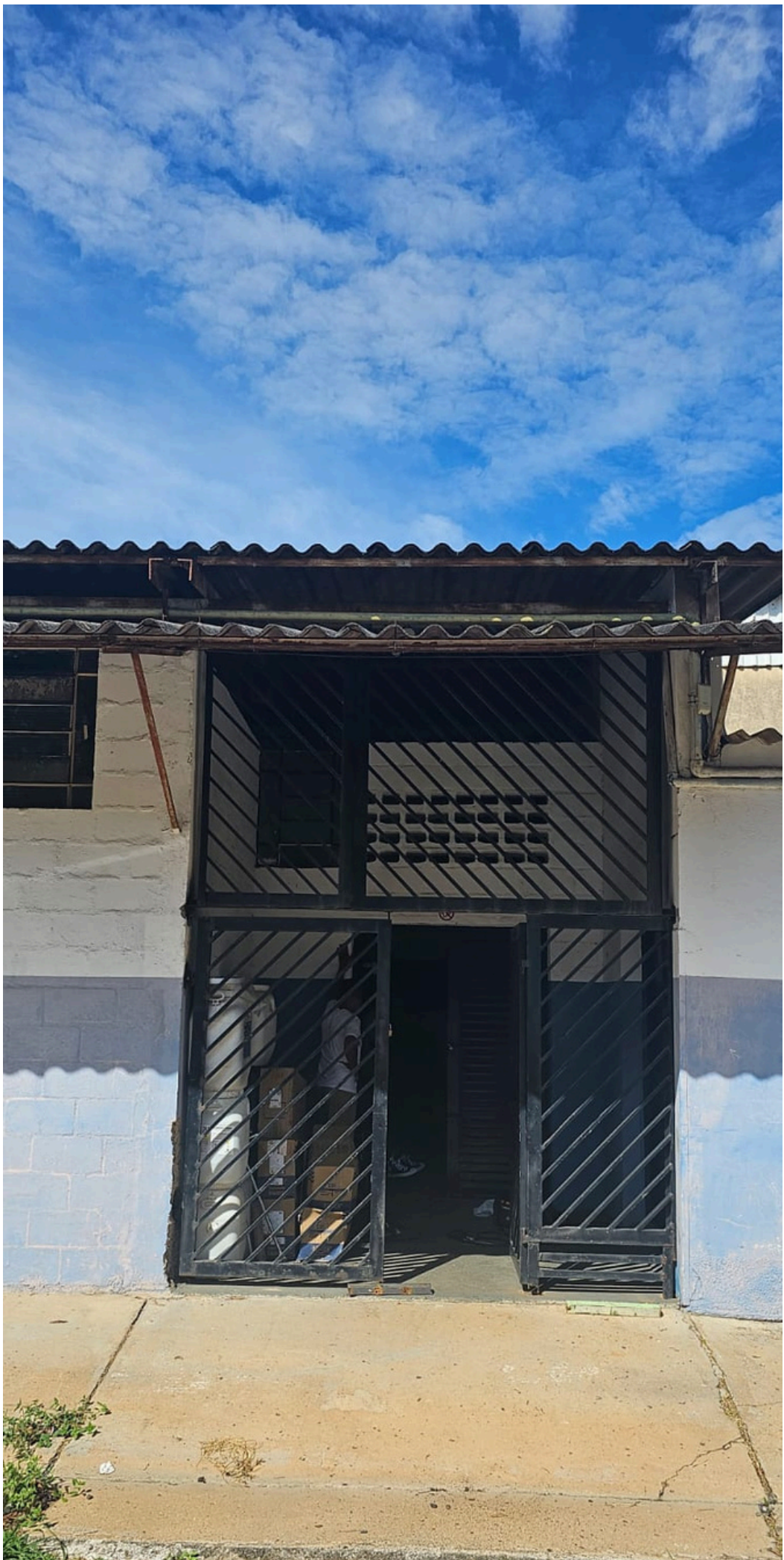
Entrada do Almoxarifado
