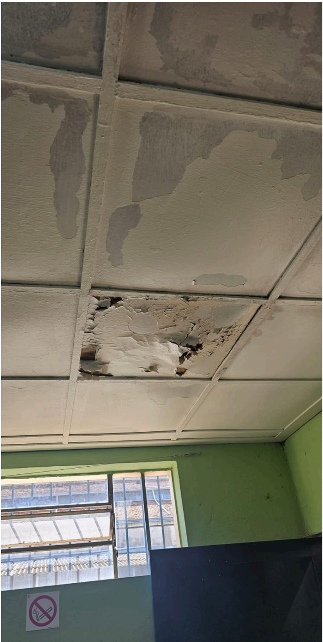
Escritório do Almojarifado
