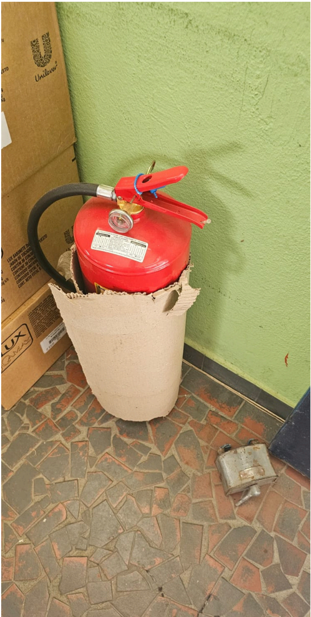
Escritório do Almojarifado
