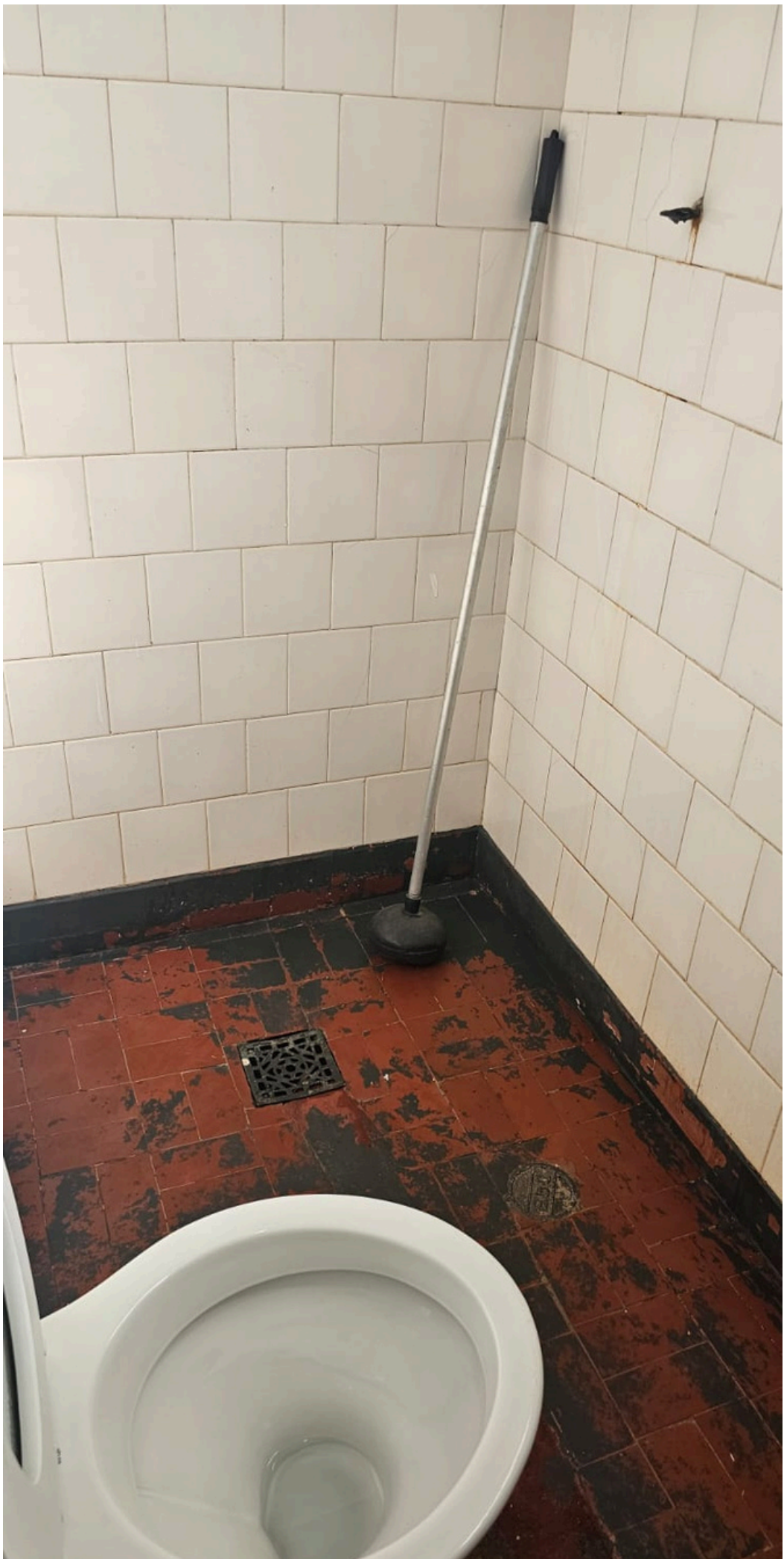
Banheiro do Almojarifado
