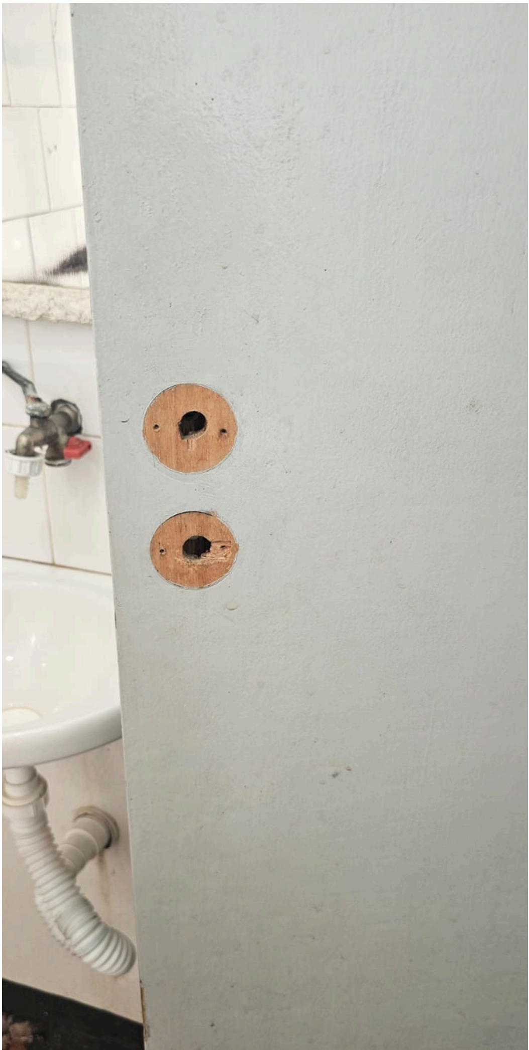
Banheiro do Almojarifado
