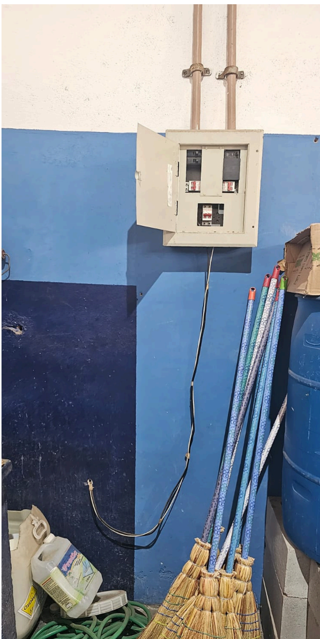
Área de Armazenamento do Almojarifado
