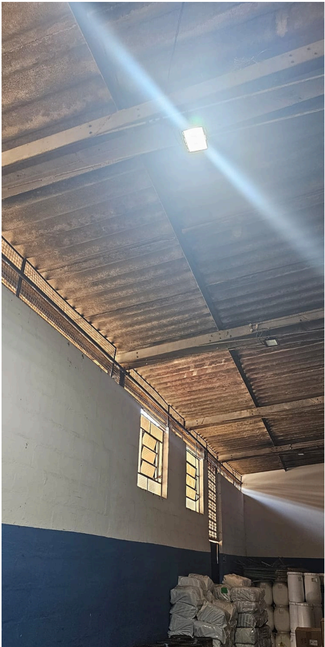
Área de Armazenamento do Almojarifado
