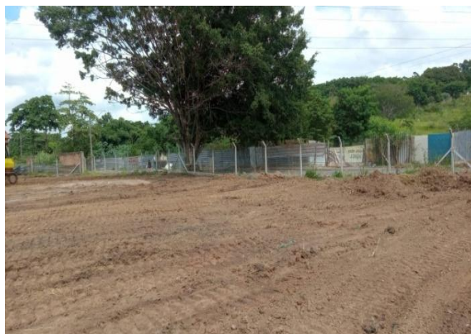
Figura 5. Local após a limpeza.
