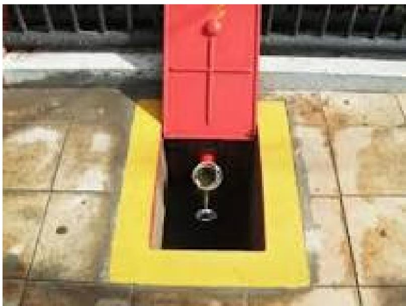
O Hidrante de Recalque é instalado em calçadas ou colunas, portanto, nas áreas externas das edificações sendo um aparelho essencial para que o Corpo de Bombeiros possa combater incêndios com maior segurança e efetividade.
