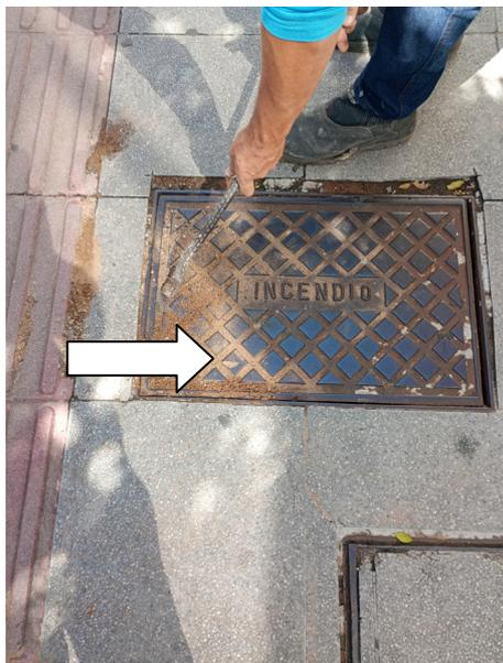
Neste local já havia um suposto ponto de vazamento de água na rede de hidrantes, que culminou com rompimento do mesmo trecho da tubulação, durante um teste de partida de bomba da rede de incêndio
