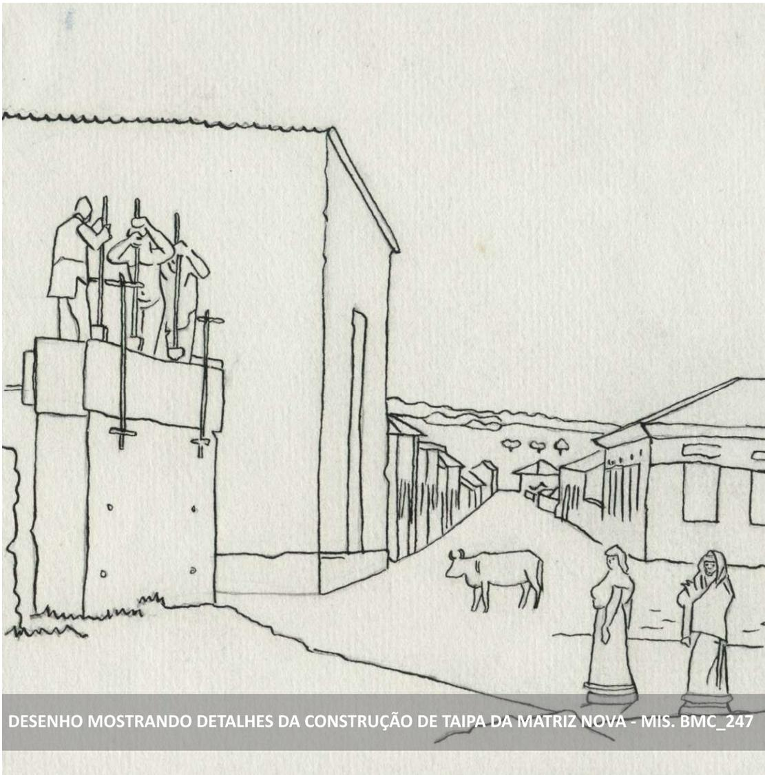
DESENHO MOSTRANDO DETALHES DA CONSTRUÇÃO DE TAIPA DA MATRIZ NOVA - MIS. BMC\_247
