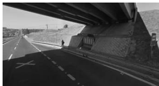
1 – Acesso ao ponto de parada do TC
