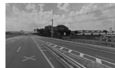
Rod. Anhanguera, acesso da pista marginal Fonte: Google Street View (2015)
