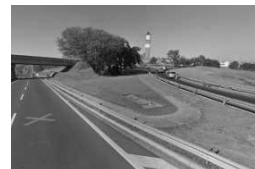
2 – Travessia, ponto de parada de TC e acesso ao Swiss Park Empresarial
