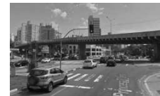
(4) Av. Dr. Moraes Sales x Perimetral Reboucas (BRT) Fonte: Google Street View (2015).
