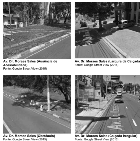
Figura 5.10.2-10 – Trecho SO1 – Av. Dr. Moreira Sales
