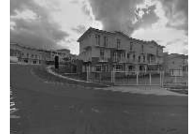
Residência de alto padrão Fonte: Google Street View (2011).
