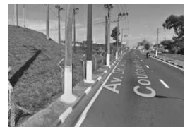
Av. Couto de Barros (Postes na calçada) Fonte: Google Street View (2015)
