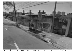
Av. Ângelo Simões (Calçada esburacada) Fonte: Google Street View (2015)
