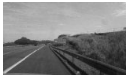
Rodovia dos Bandeirantes Fonte: TTC (2016).
