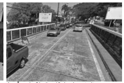
Av. Ângelo Simões (Calçada estreita em viaduto de transposição a linha férrea) Fonte: Google Street View (2015)
