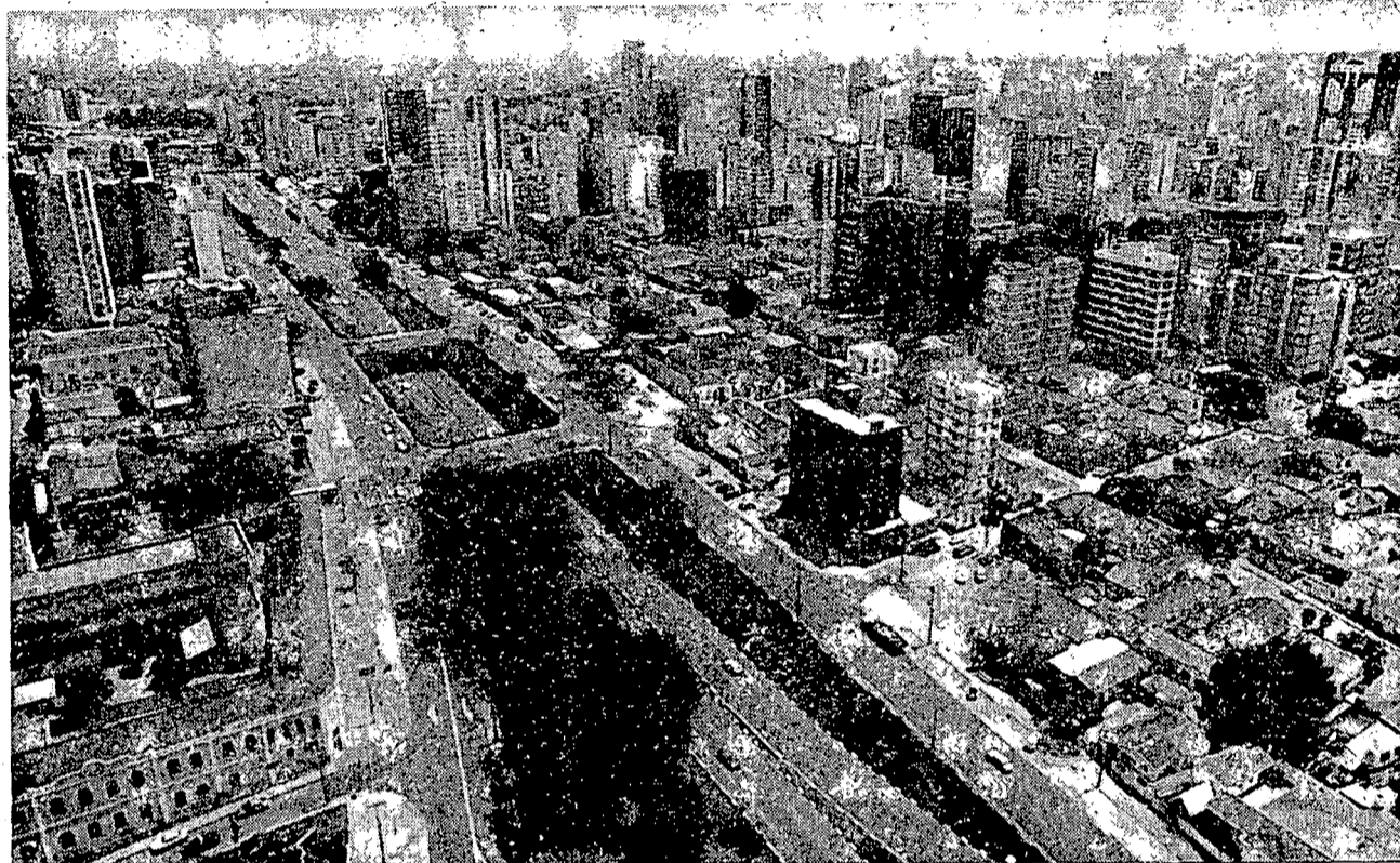
O levantamento aéreo realizado em Campinas identificou 8.885 casas irregulares
