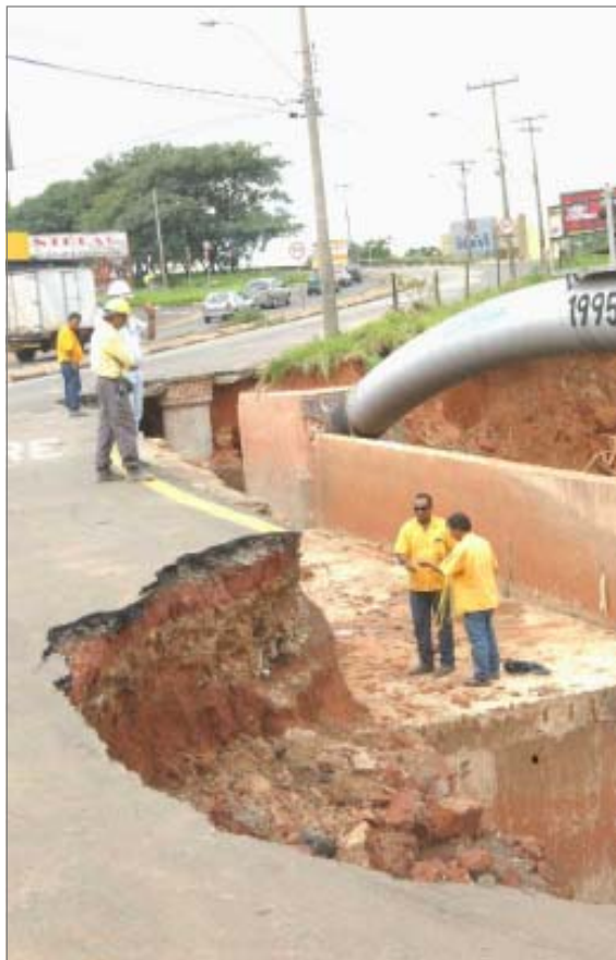
Trabalhadores reparam estrago em adutora
