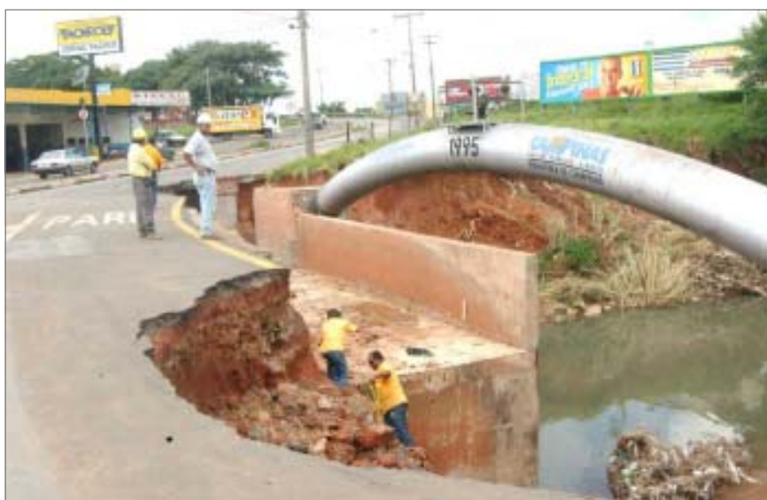
Trabalhadores reparam estragos causados pela forte chuva do dia 17
