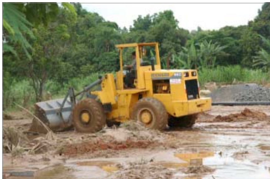
Após enchente, máquina da Prefeitura retira lama na região de Sosas
