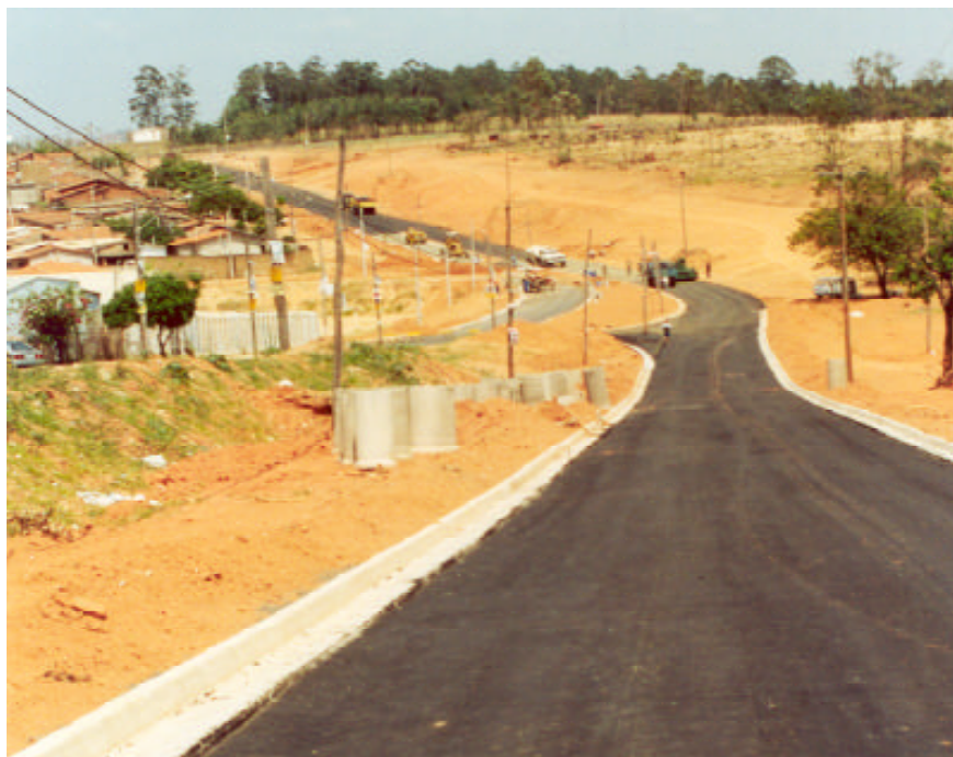
Trecho da Dunlop entre o Itajaí e o Campina Grande: obra definida pelo OP
