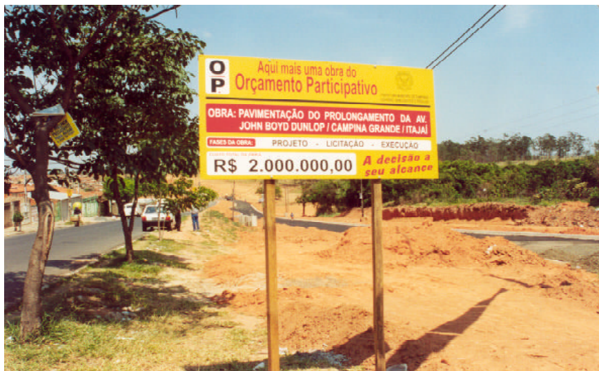
Trecho da Dunlop, cuja pavimentação será entregue hoje, no Campina Grande
