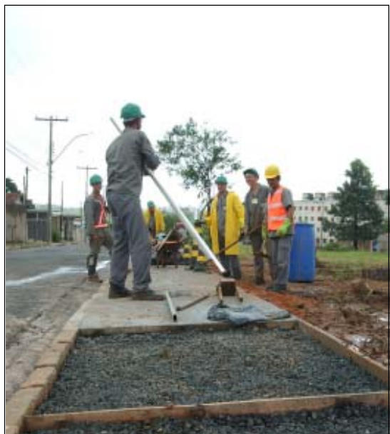
Área de 16 mil m 2 está sendo remodelada
