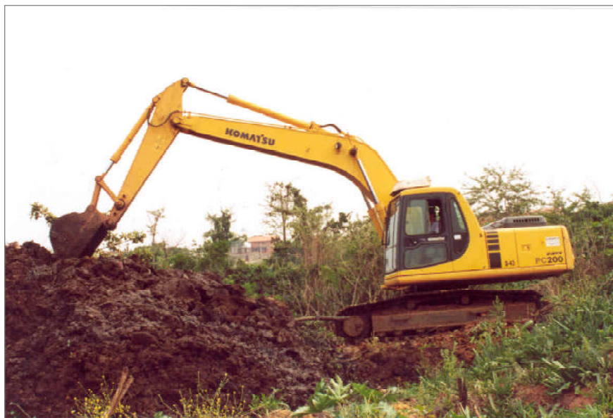
Dragagem de córrego evitará enchentes no Parque Via Norte durante as chuvas
