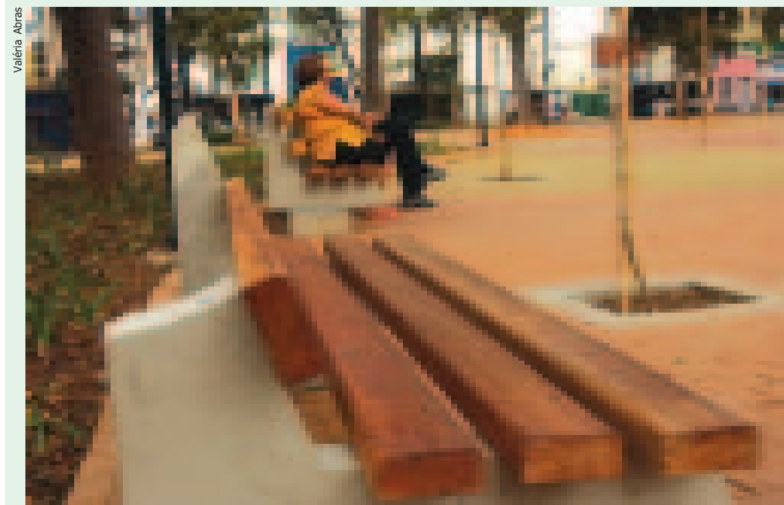
Banco com a base de concreto quebrada: freqüentador da praça é o maior prejudicado
