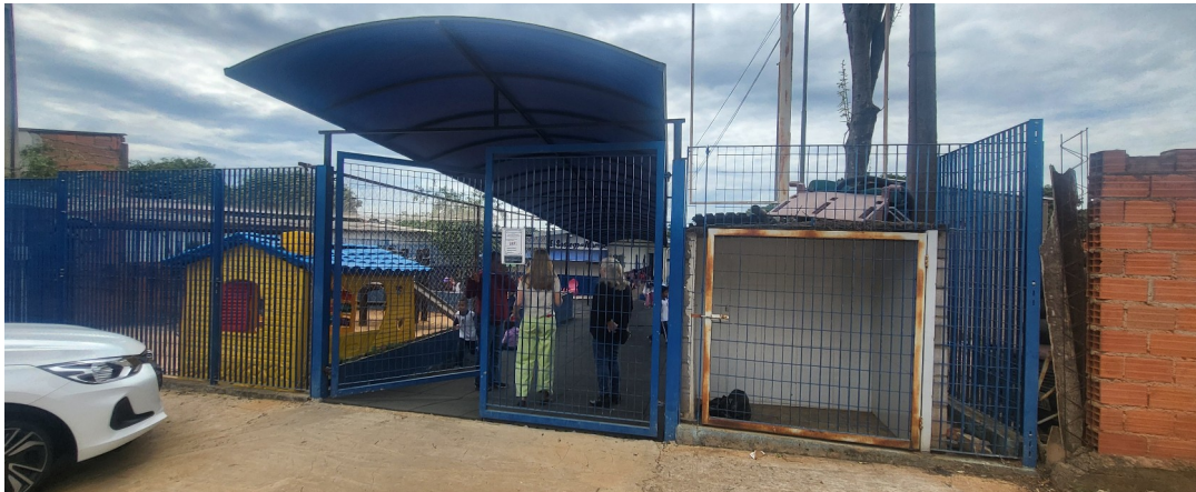
Figura 1: CEI Sossego da Mamãe - Entrada sem piso tátil.
