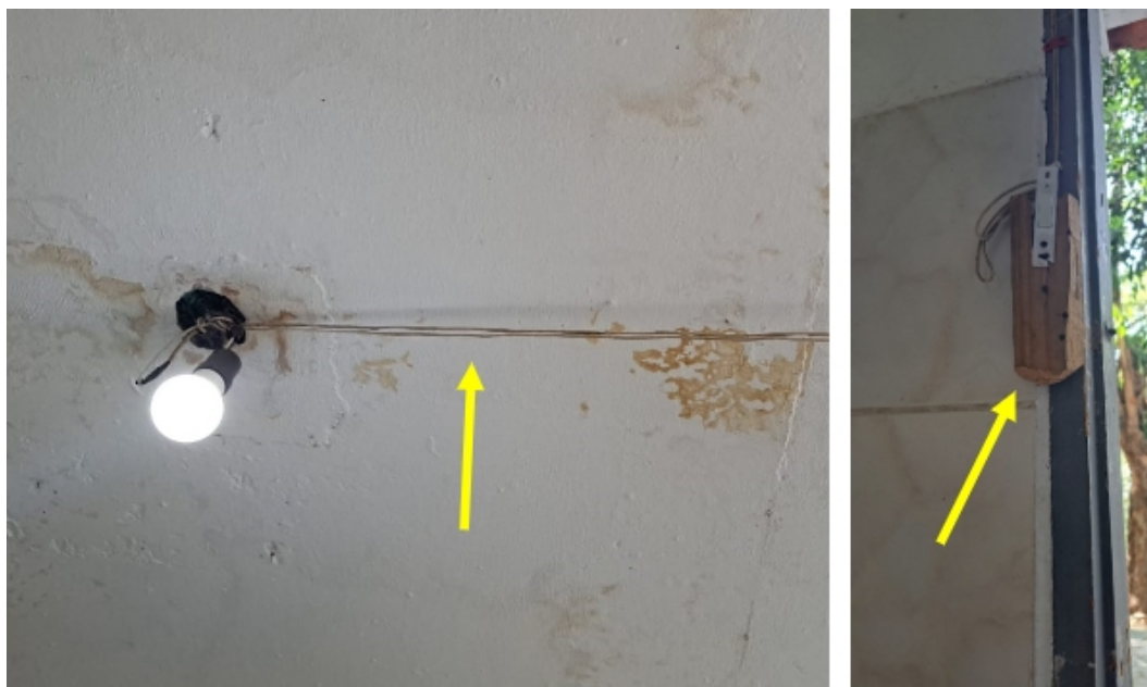
Foto 10: Fiação inadequada
