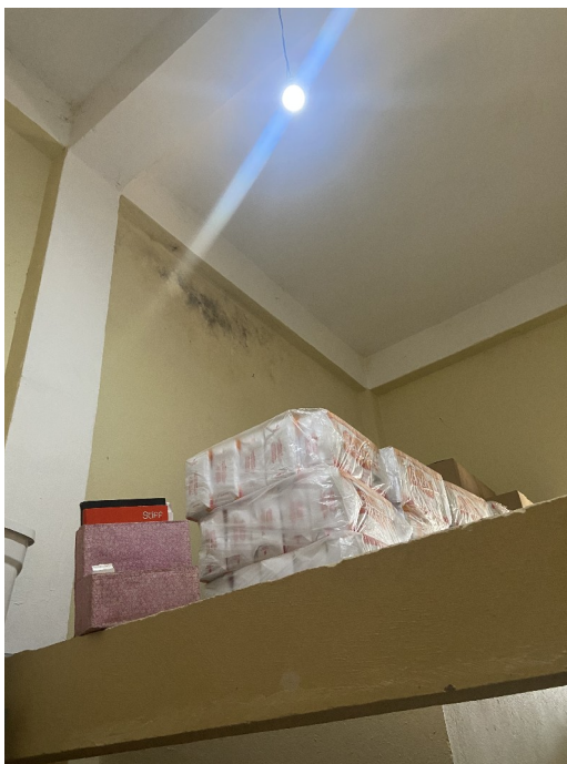
CS Aquino Neto – Mofo nas parede e teto do DML.
