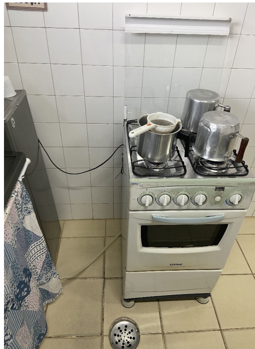
CS Aquino Neto – Posição da mangueira de gás apresenta risco de segurança.
