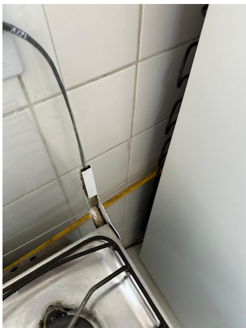
CS Santa Odila – Posição da mangueira de gás apresenta risco de segurança.
