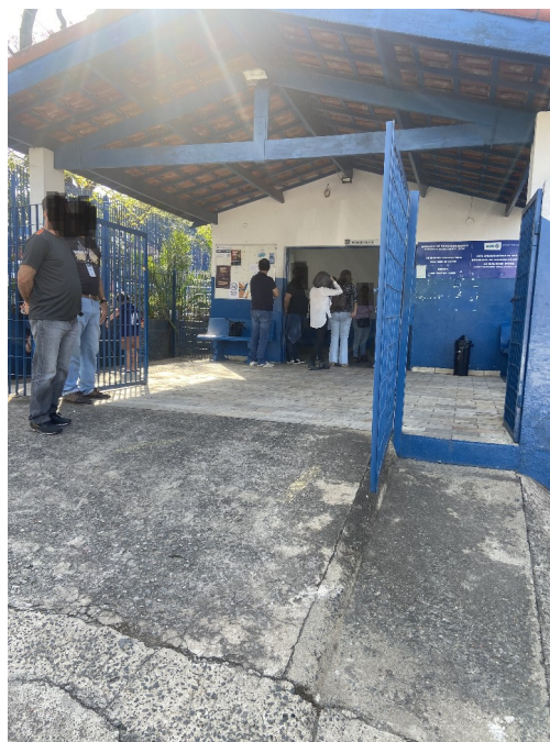
CS Santa Lúcia - Rampa de acesso com inclinação inadequada.
